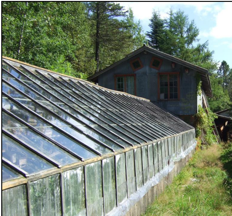
Bygningene står ennå på stedet, men plantebedene er overgrodd. (Foto Olav Kalleberg)
